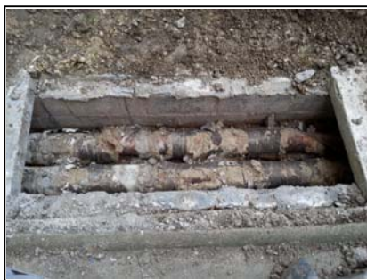
Des conduites de chauffage qui, quand elles ne fuient pas doivent plus chauffer les petits oiseaux que les locataires de Balagny compte tenu de l'état de leur isolation. COP21 quand tu nous tiens !!
